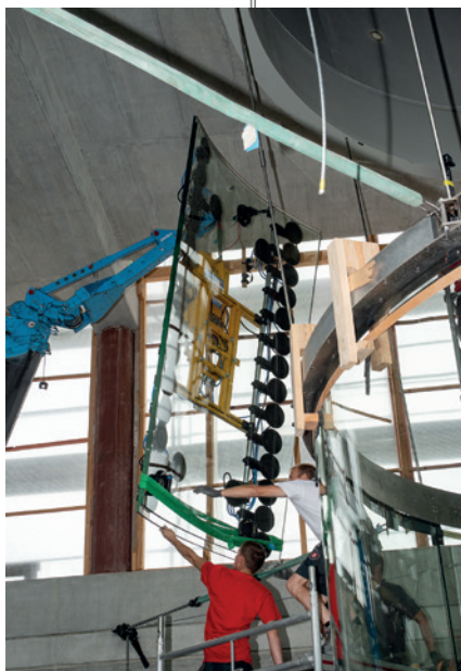
Der Montagekran MRK 144.0 S und die Vakuum-Sauganlage VSG 1000 KR beim Verglasen der Flight Chamber
