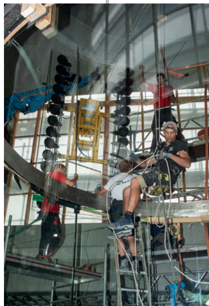
Der Montagekran MRK 144.0 S und die Vakuum-Sauganlage VSG 1000 KR beim Verglasen der Flight Chamber
