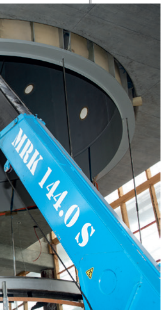
Der Montagekran MRK 144.0 S und die Vakuum-Sauganlage VSG 1000 KR beim Verglasen der Flight Chamber
