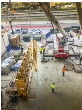
Das Scheibenelement wird mit modifizierter Glasmontage-Anlage hinter die Säule gehoben
