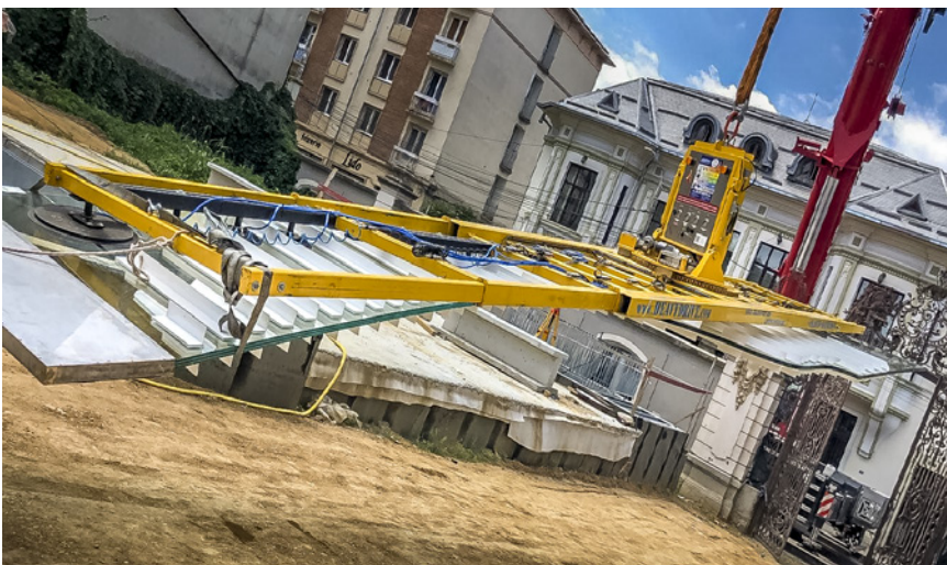
Die Heavydrive Anlage transportiert 12,5 Meter hohes, wellenförmig konstruiertes Formglas. Bildrechte: montec-gmbh.de
