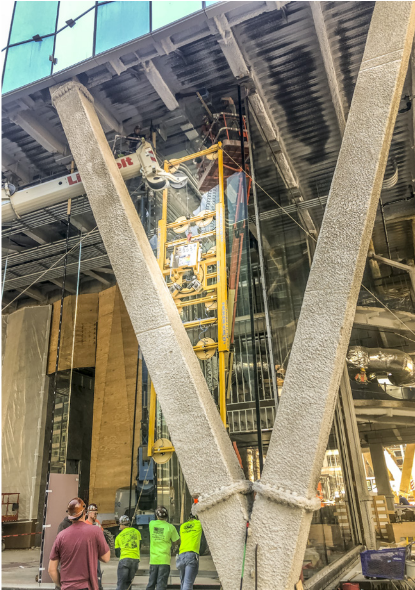
Das Scheibenelement wird mit modifizierter Glasmontage-Anlage hinter die Säule gehoben
