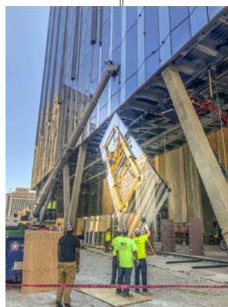
Das Scheibenelement wird mit modifizierter Glasmontage-Anlage hinter die Säule gehoben
